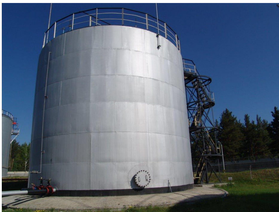
Рисунок 1 – Общий вид резервуара РВС-700
