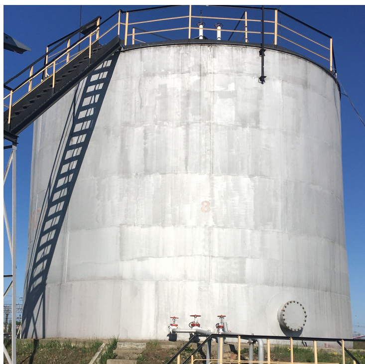
Рисунок 1 – Общий вид резервуара РВС-700
