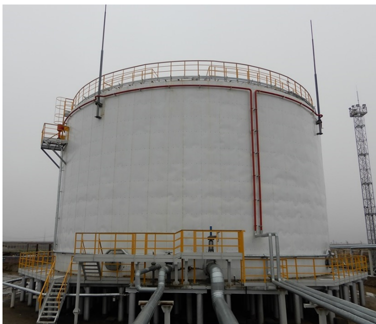
Рисунок 1 – Общий вид резервуара РВС-5000
