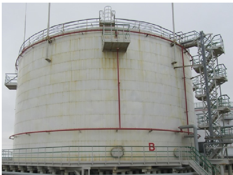
Рисунок 1 – Общий вид резервуара РВС-5000
