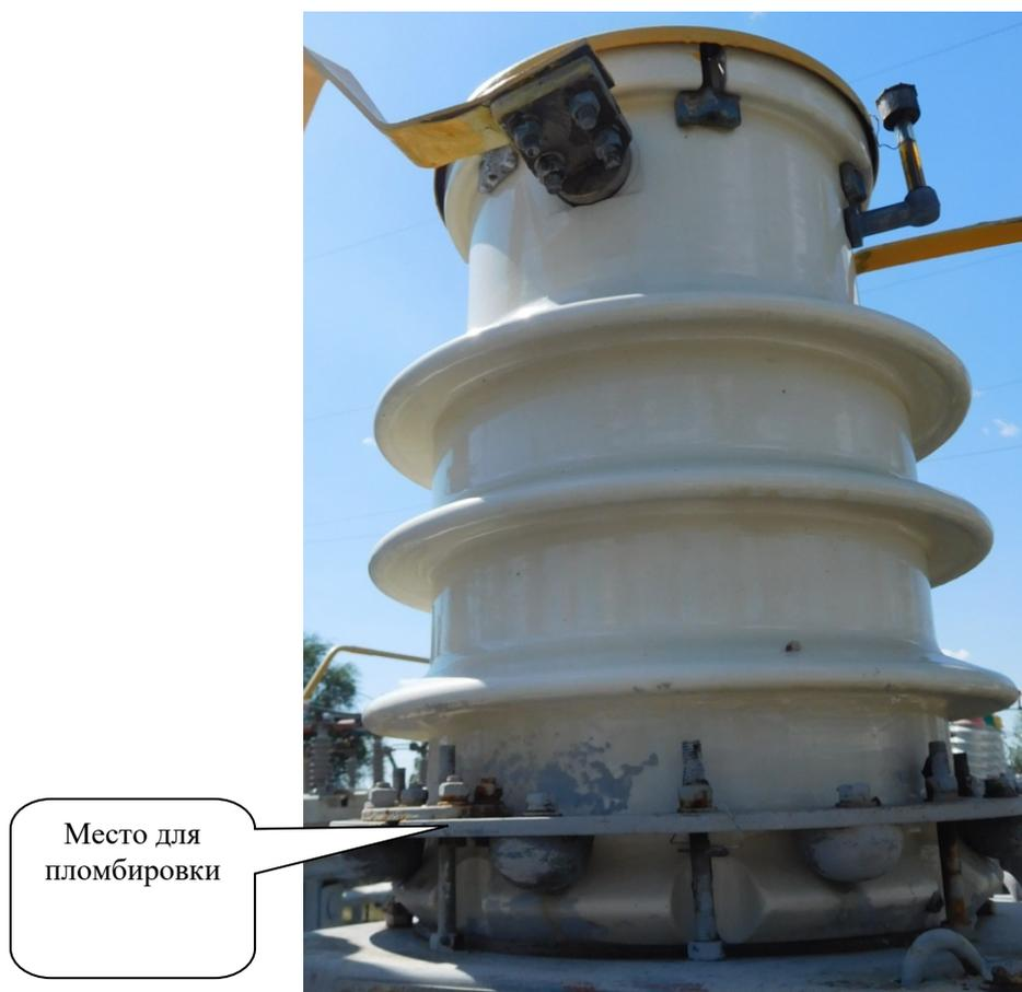
Рисунок 1 – Общий вид трансформатора тока ТФН-35М и схема пломбировки
