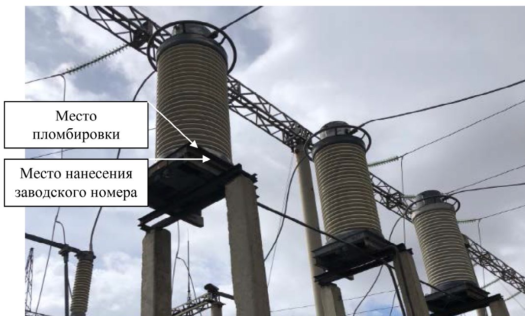
Рисунок 1. Общий вид средства измерений с указанием места пломбировки, места нанесения заводского номера
