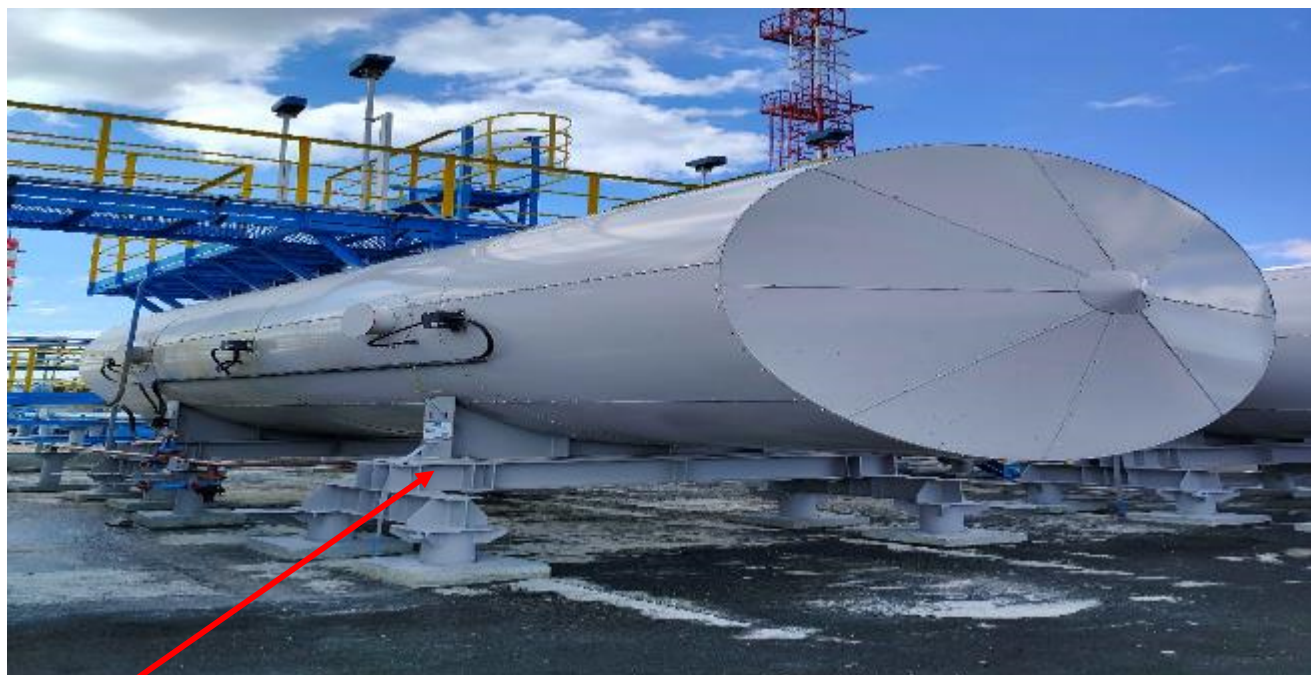
Рисунок 2 - Общий вид резервуаров горизонтальных стальных цилиндрических ГЭЭ-50 с заводским номером 207-19-50
