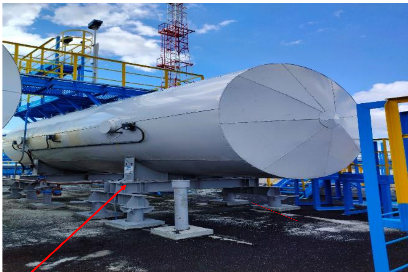
Рисунок 1 - Общий вид резервуаров горизонтальных стальных цилиндрических ГЭЭ-50 с заводским номером 206-19-50
