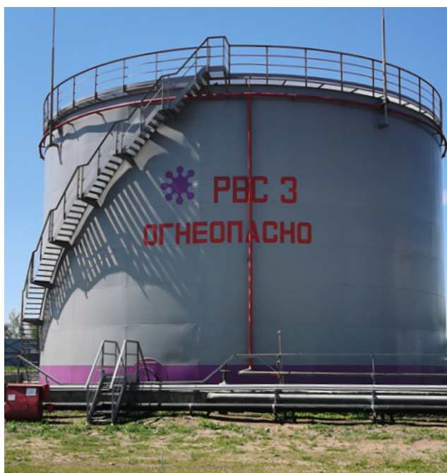
Рисунок 1 – Общий вид резервуара РВС-3000
