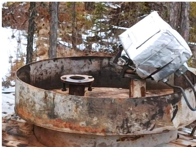
Рисунок 3 – Общий вид горловин и замерных люков резервуаров РГСН-50
