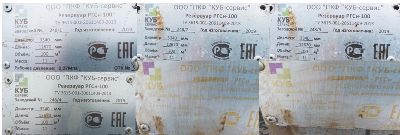
Рисунок 5 – Место нанесения заводских номеров резервуаров РГСН-100
