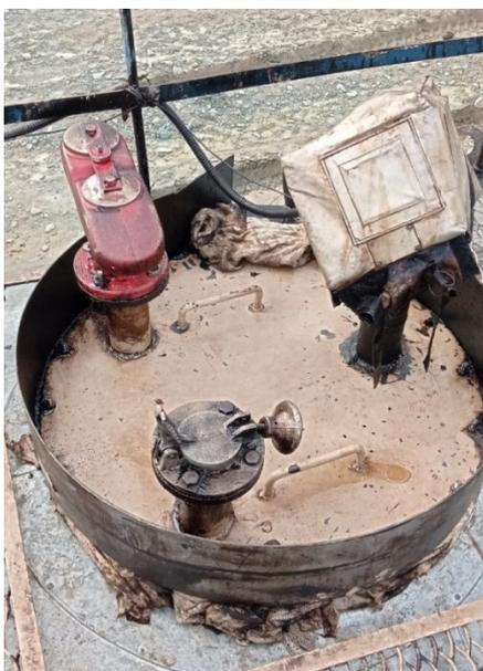
Рисунок 6 – Общий вид горловин и замерных люков резервуаров РГСН-100
