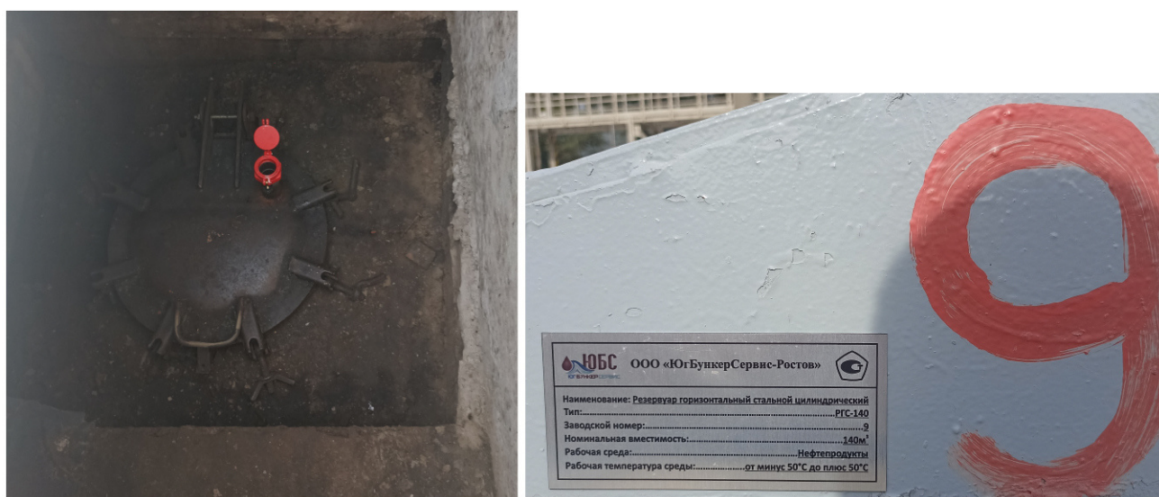
Рисунок 6 – Люк резервуара РГС-140 зав.№9 с указанием места нанесения заводского номера
