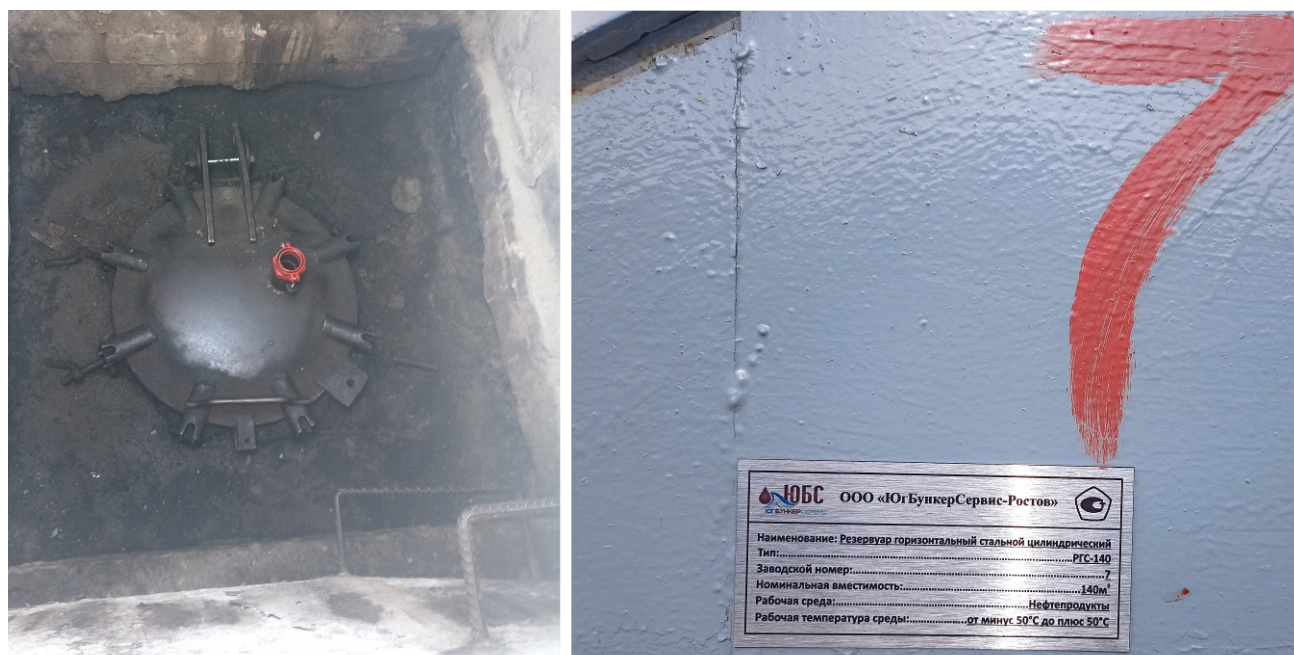
Рисунок 4 – Люк резервуара РГС-140 зав.№7 с указанием места нанесения заводского номера
