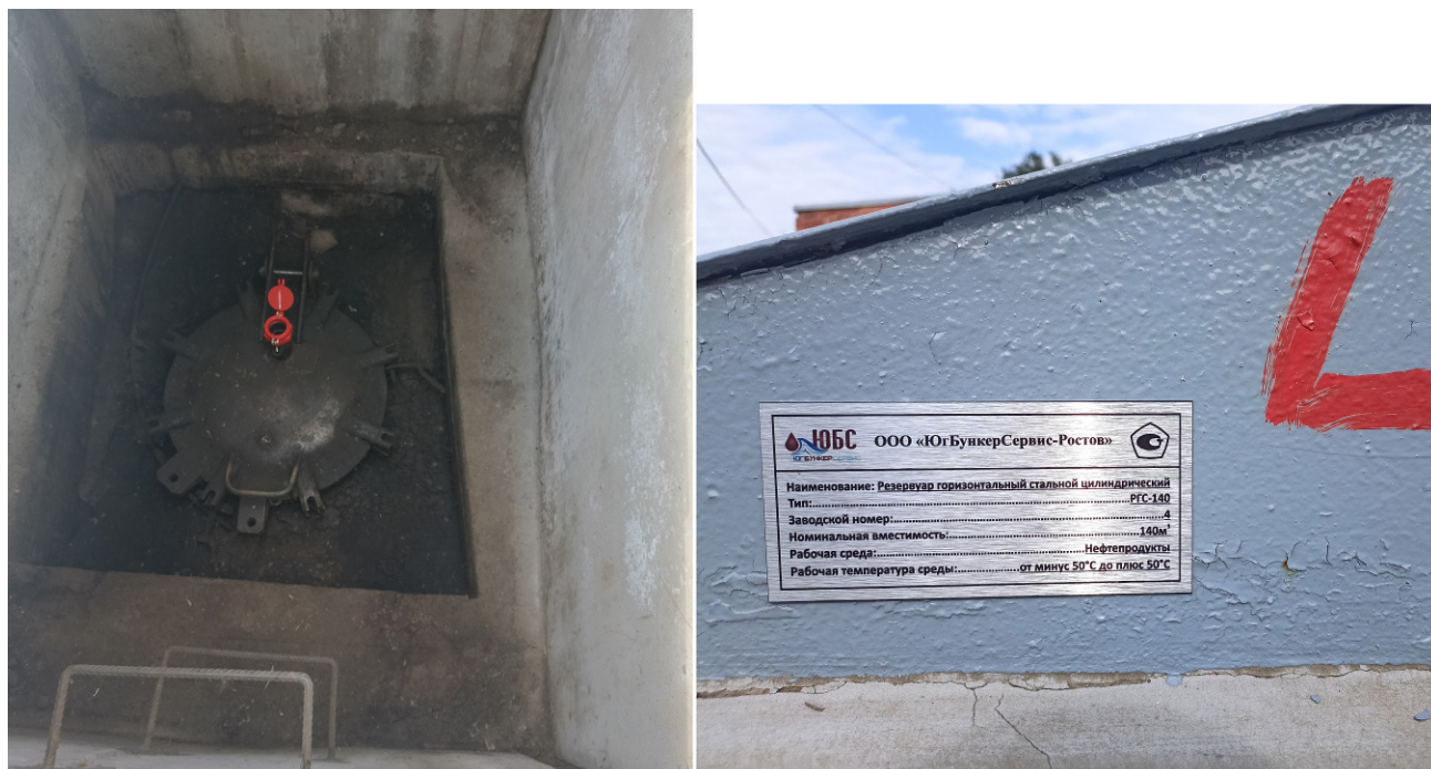
Рисунок 1 – Люк резервуара РГС-140 зав.№4 с указанием места нанесения заводского номера
