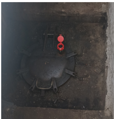
Рисунок 9 – Люк резервуара РГС-140 зав.№12 с указанием места нанесения заводского номера
