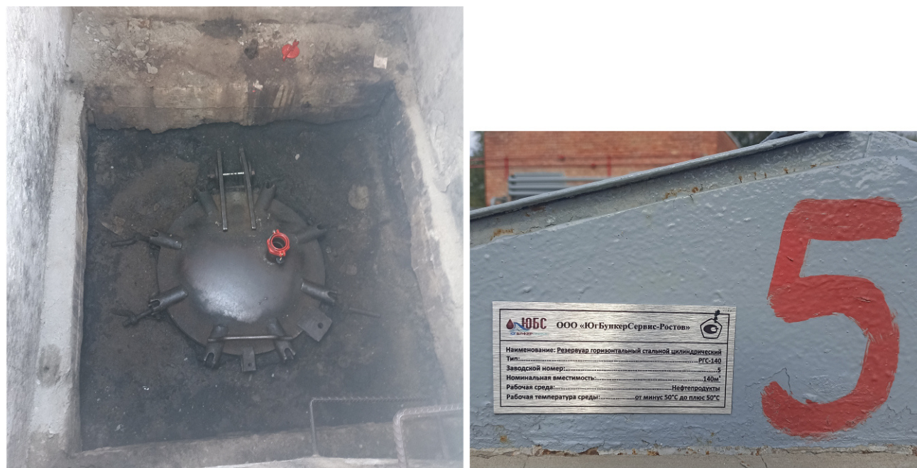
Рисунок 2 – Люк резервуара РГС-140 зав.№5 с указанием места нанесения заводского номера
