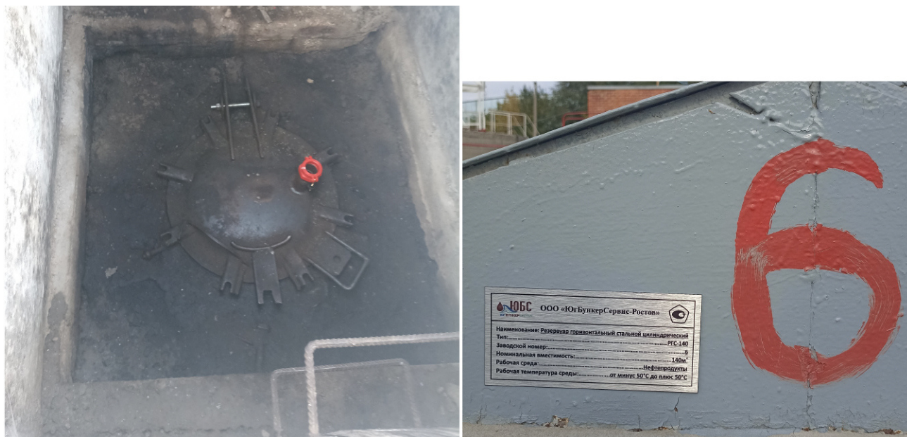
Рисунок 3 – Люк резервуара РГС-140 зав.№6 с указанием места нанесения заводского номера
