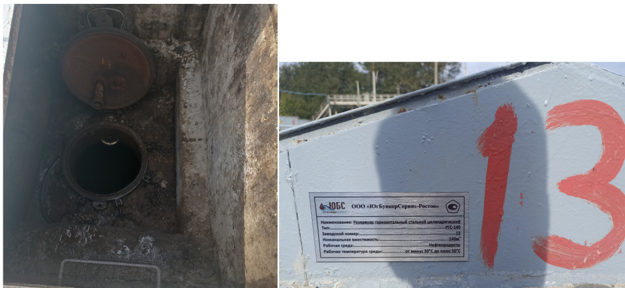
Рисунок 10 – Люк резервуара РГС-140 зав.№13 с указанием места нанесения заводского номера
