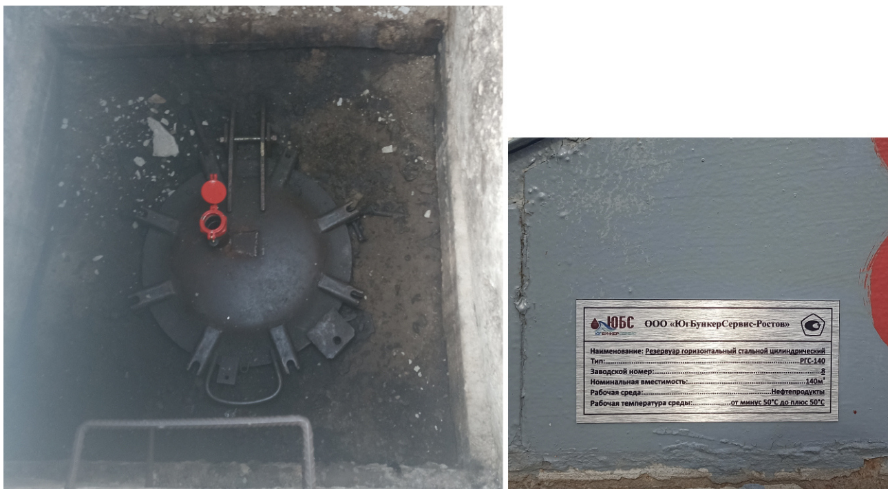
Рисунок 5 – Люк резервуара РГС-140 зав.№8 с указанием места нанесения заводского номера
