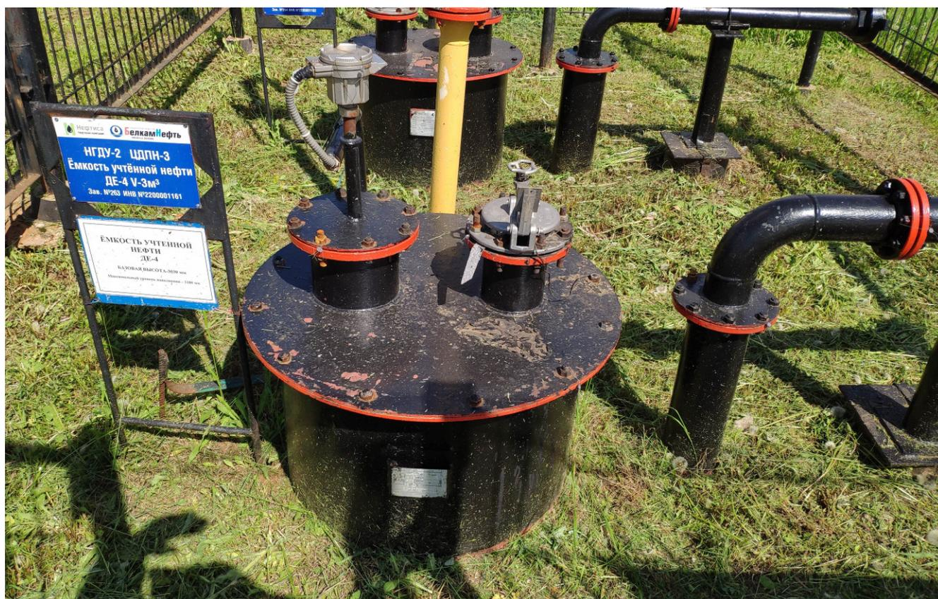
Рисунок 3 – Горловина и измерительный люк резервуара
