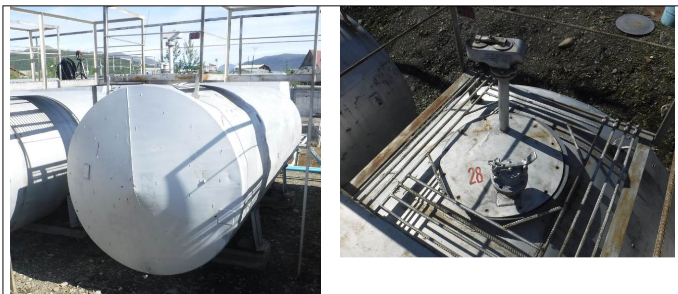
Рисунок 2 – Общий вид резервуаров РГС-50 (№28) с замерным люком
