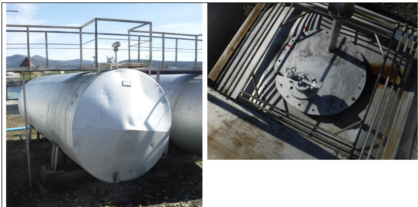
Рисунок 1 – Общий вид резервуаров РГС-50 (№26) с замерным люком
