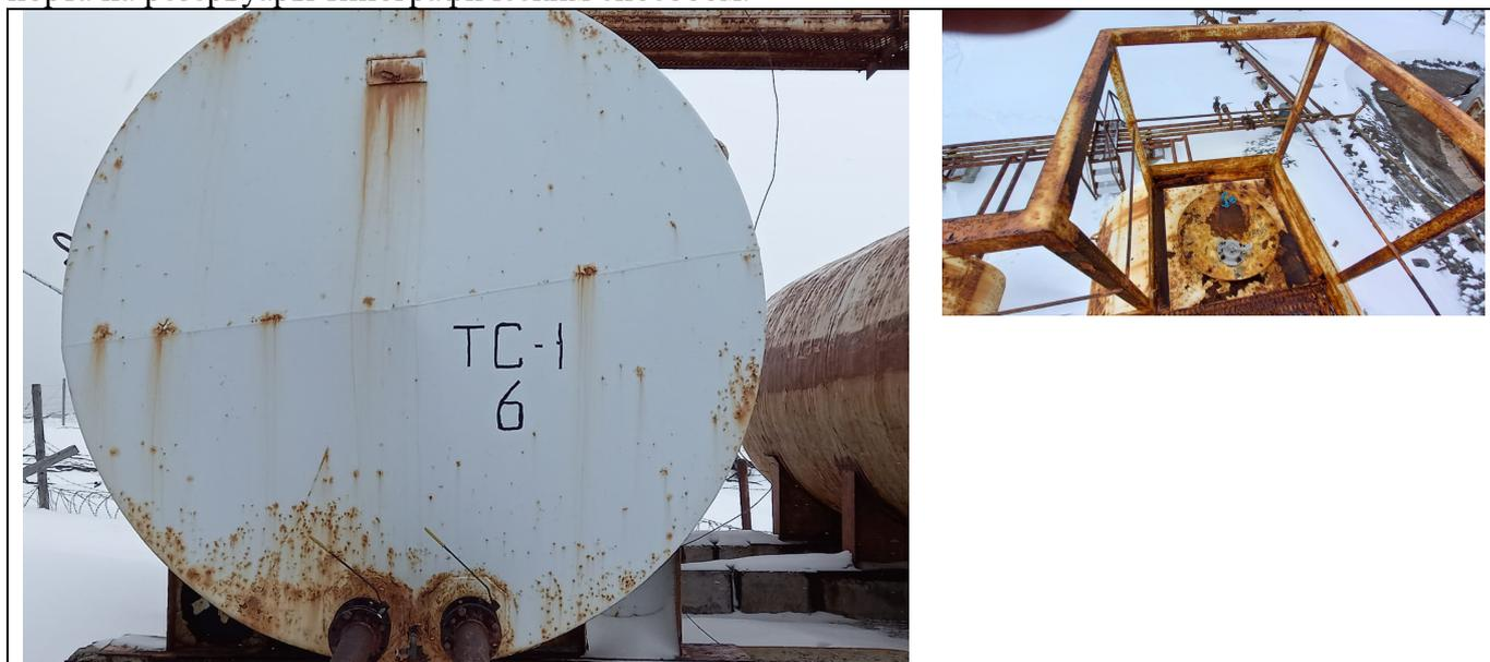
Рисунок 1 – Общий вид резервуаров РГС-60 (№6) с замерным люком
