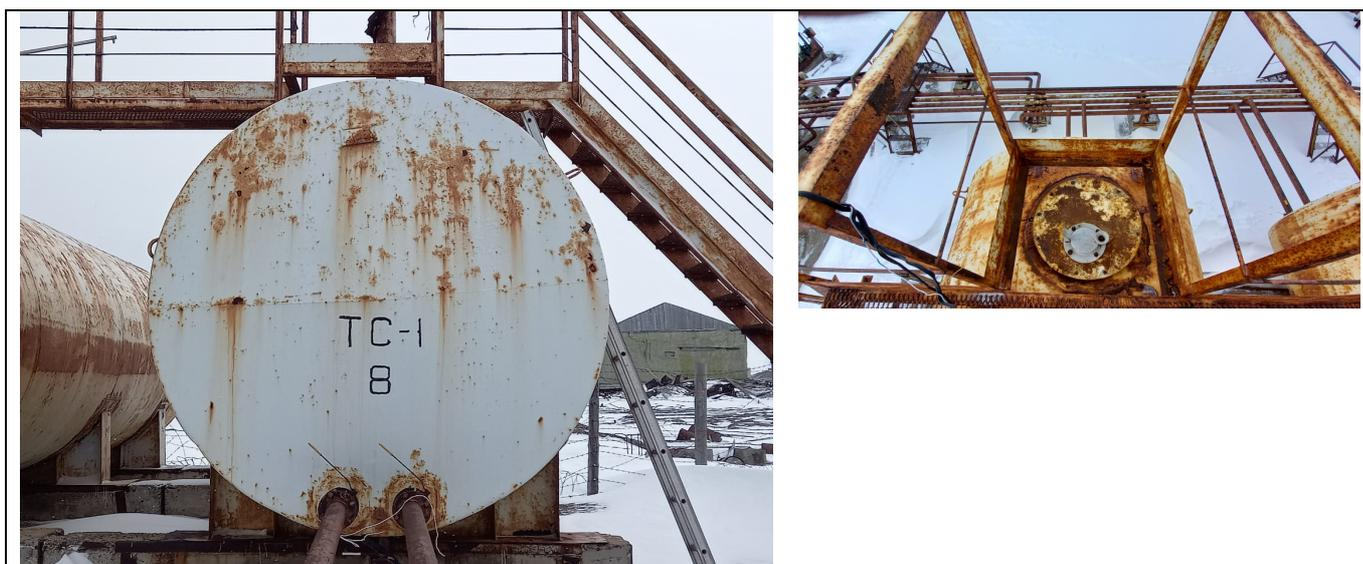
Рисунок 3 – Общий вид резервуаров РГС-60 (№8) с замерным люком
