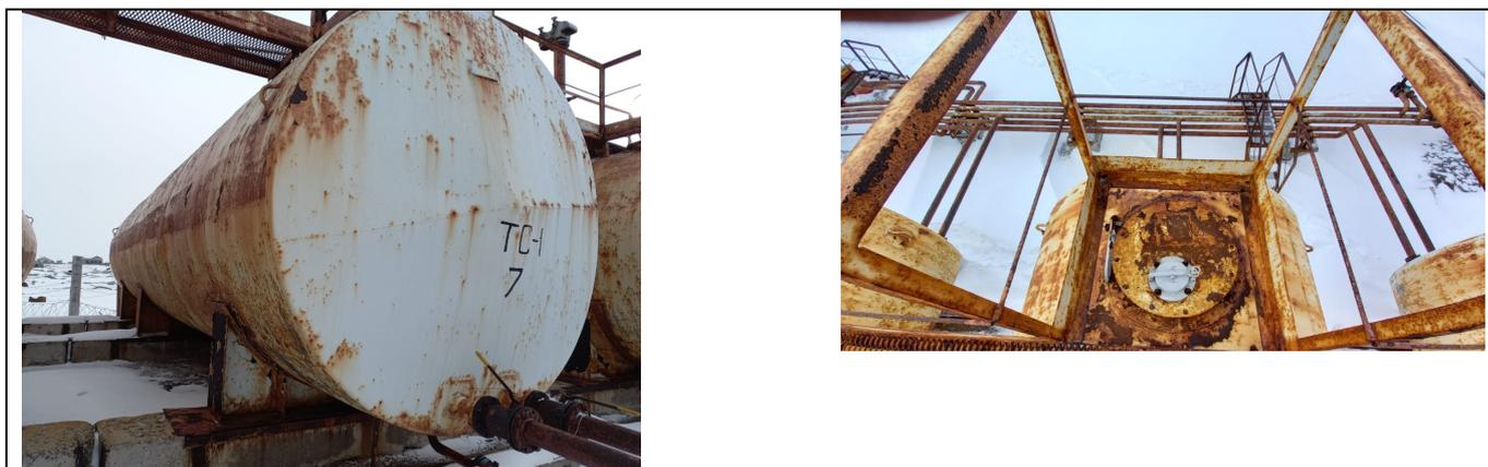
Рисунок 2 – Общий вид резервуаров РГС-60 (№7) с замерным люком
