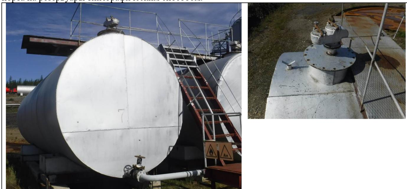
Рисунок 1 – Общий вид резервуаров РГС-50 (№7) с замерным люком
