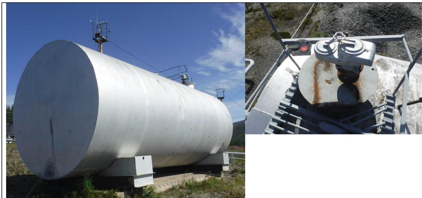
Рисунок 2 – Общий вид резервуаров РГС-50 (№8) с замерным люком
