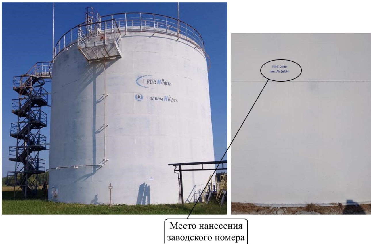
Рисунок 1 – Общий вид резервуара РВС-2000 №26334 с указанием места нанесения заводского номера
