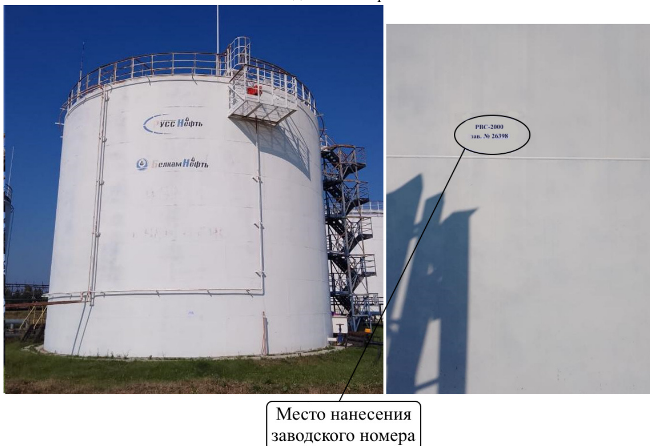
Рисунок 2 – Общий вид резервуара РВС-2000 №26398 с указанием места нанесения заводского номера
