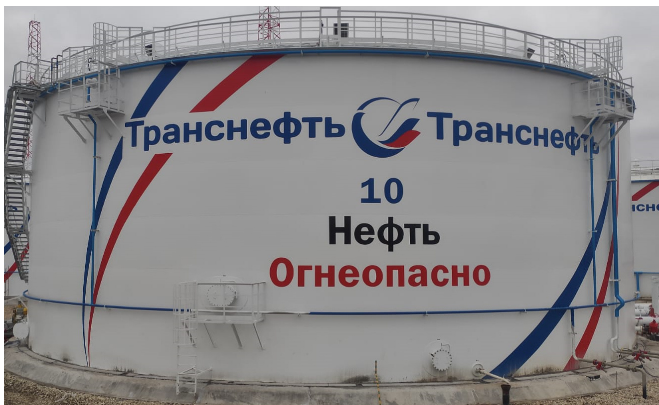
Рисунок 2 – Общий вид резервуара РВСП-10000 №10
