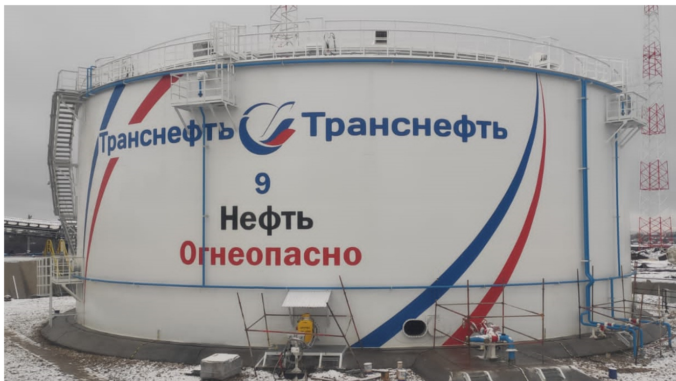
Рисунок 1 – Общий вид резервуара РВСП-10000 №9
