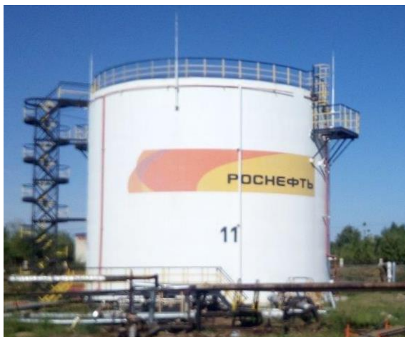
Рисунок 1 – Общий вид резервуара РВС-2000
