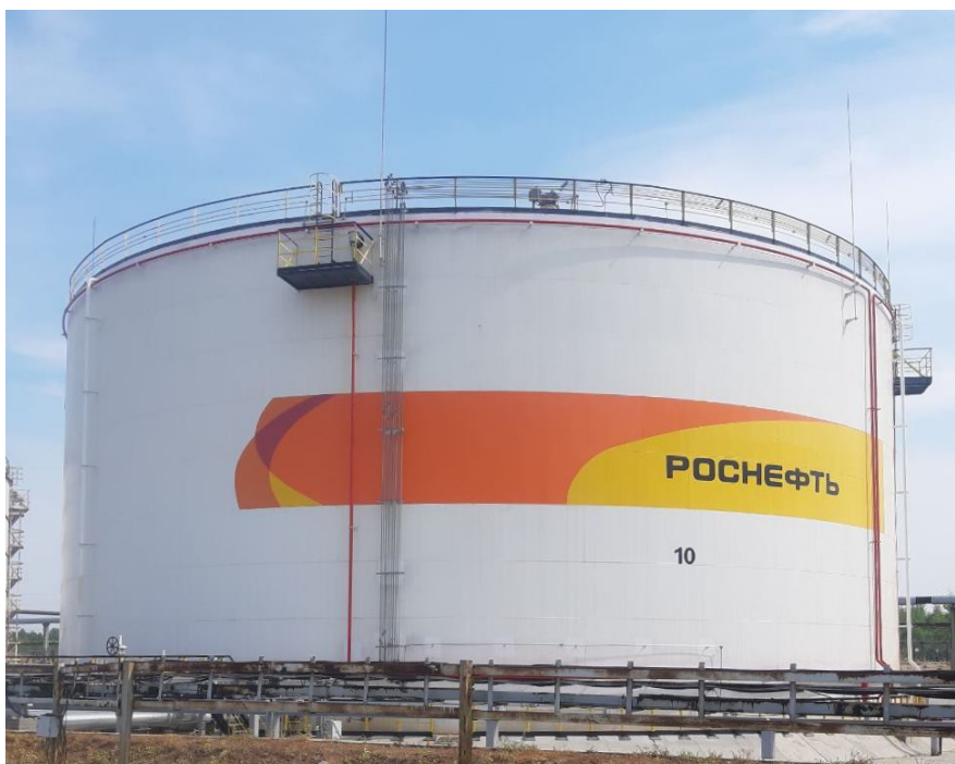
Рисунок 1 – Общий вид резервуара РВСП-20000
