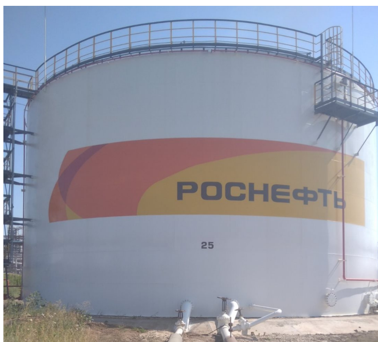
Рисунок 1 – Общий вид резервуаров РВС-5000
