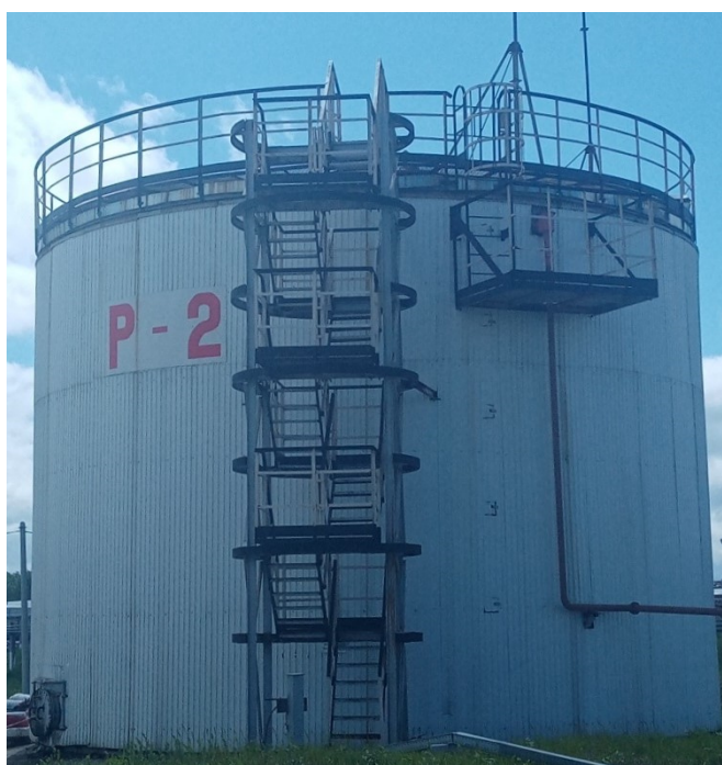
Рисунок 1 – Общий вид резервуара РВС-1000
