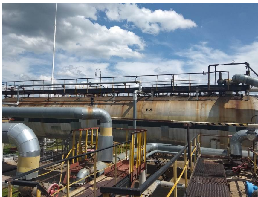
Рисунок 1 – Общий вид резервуаров РГС-200
