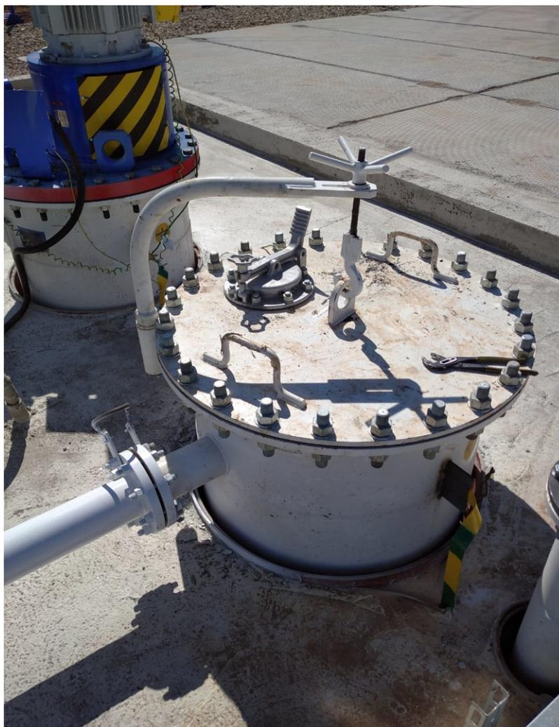
Рисунок 3 – Горловины и измерительный люк резервуара
