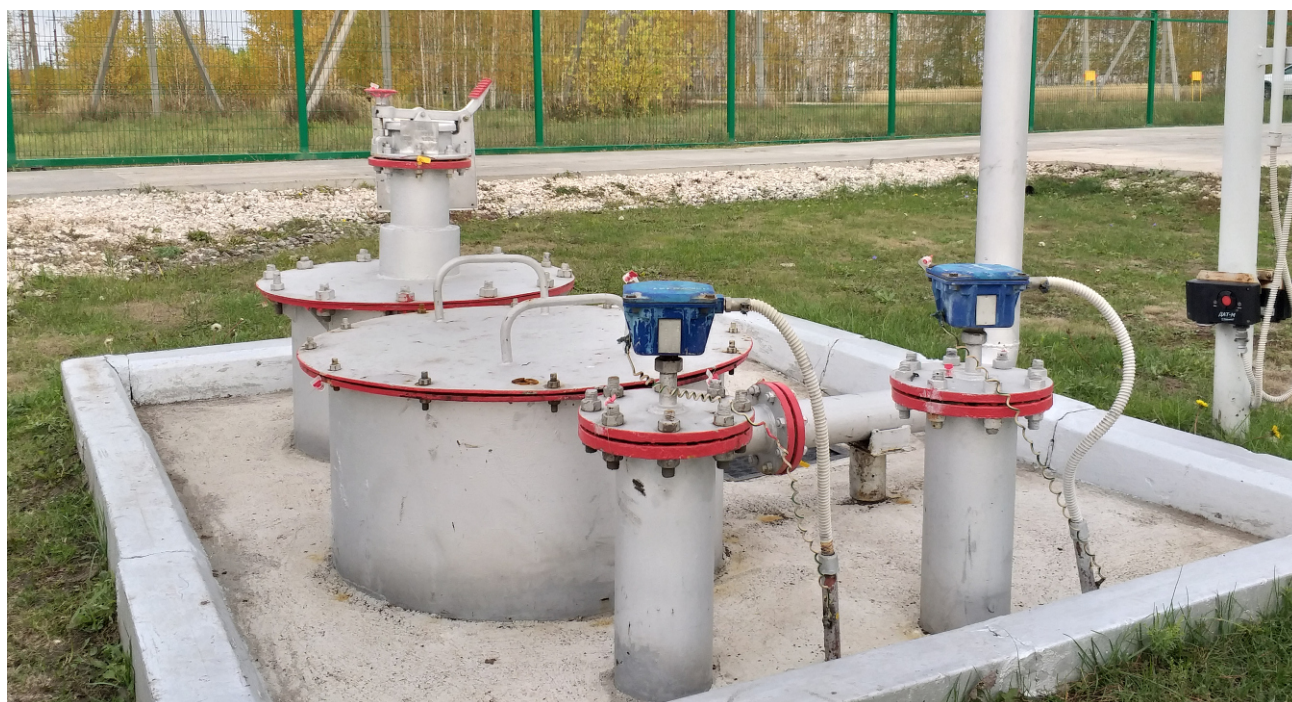
Рисунок 2 – Общий вид резервуара РГС-8
