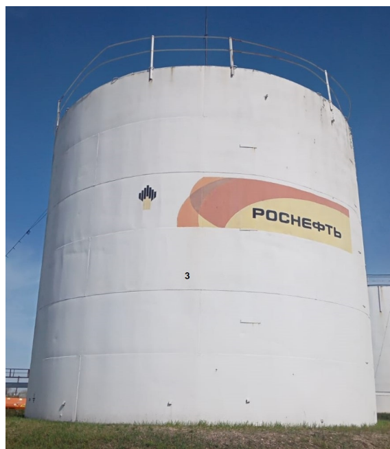
Рисунок 1 – Общий вид резервуара РВС-700
