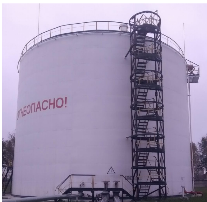
Рисунок 1 – Общий вид резервуаров РВСП-5000
