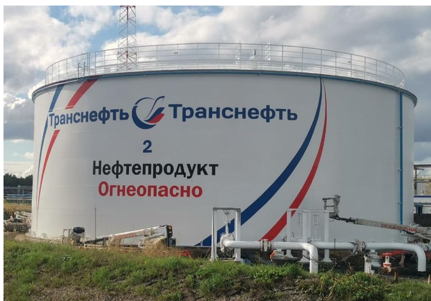
Рисунок 1 – Общий вид резервуара
