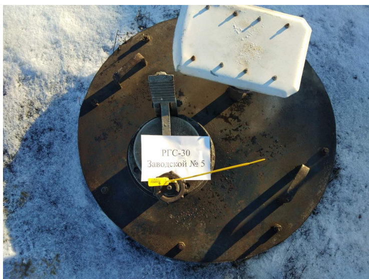
Рисунок 2 – Общий вид резервуара РГС-30 № 5
