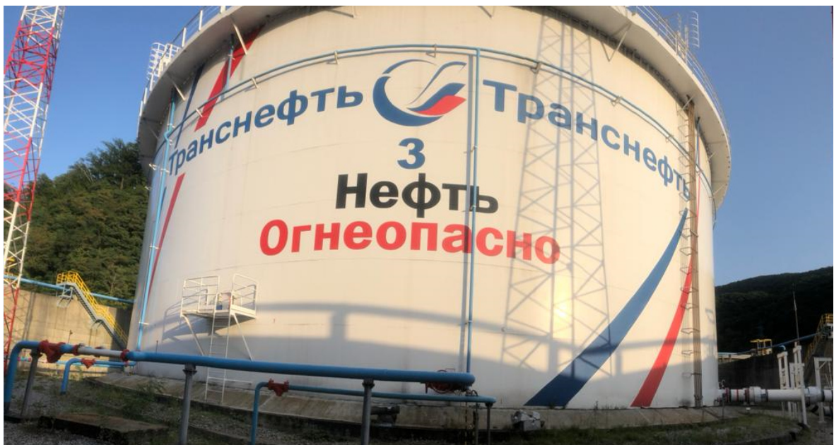
Рисунок 1 – Общий вид резервуара
