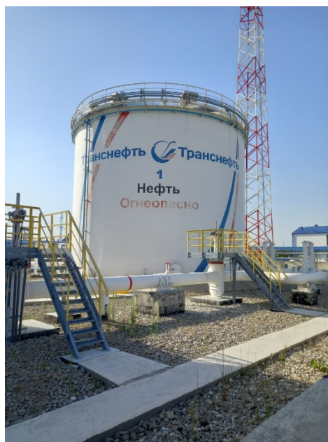
Рисунок 1 – Общий вид резервуаров
