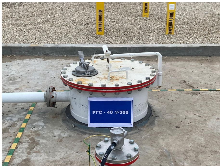
Рисунок 2 – Общий вид надземной части резервуара РГС-40 № 300
