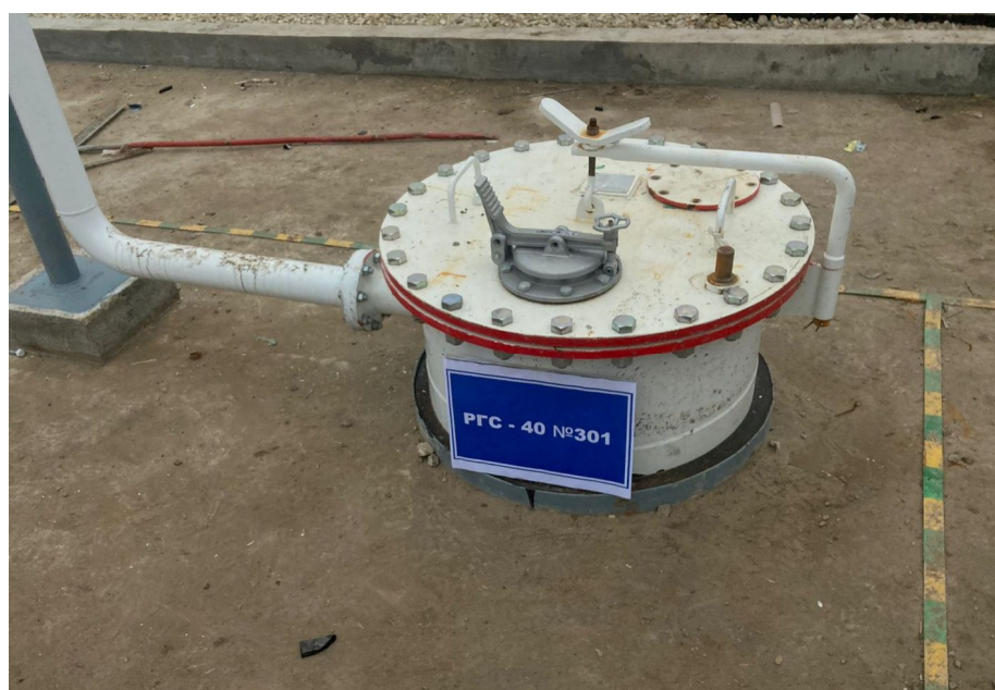
Рисунок 3 – Общий вид надземной части резервуара РГС-40 № 301
