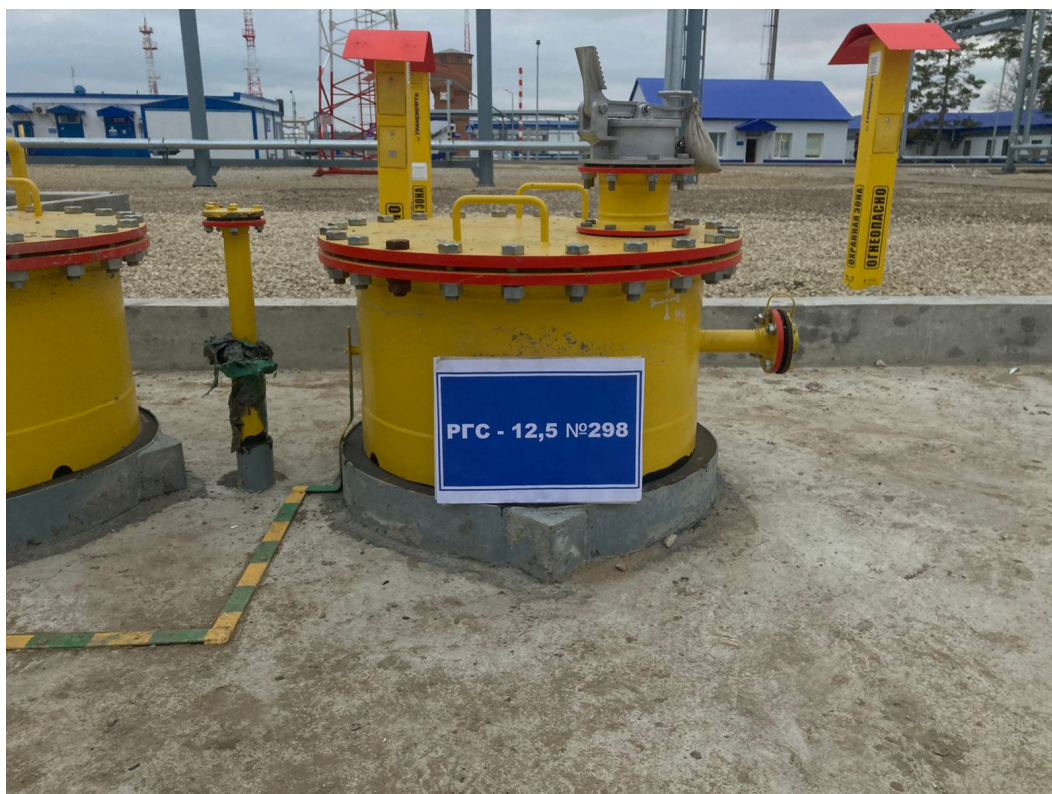
Рисунок 2 – Общий вид надземной части резервуара РГС-12,5
