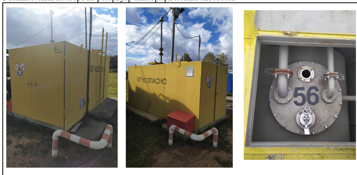
Рисунок 1 – Общий вид резервуара РГС-5 с замерным люком
