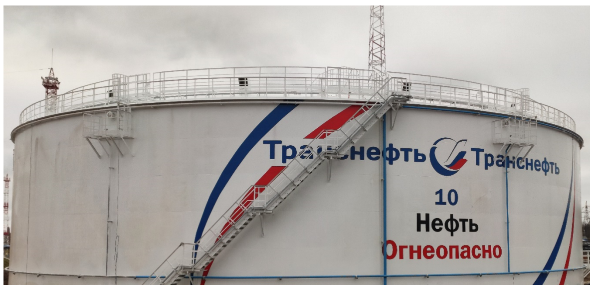
Рисунок 1 – Общий вид резервуара
