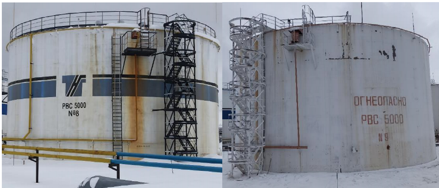
Рисунок 1 – Общий вид резервуаров с заводским номером 8 и 9
