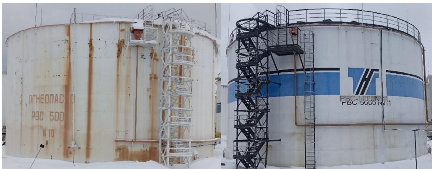
Рисунок 2 – Общий вид резервуаров с заводским номером 10 и 11
