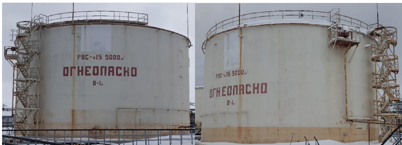
Рисунок 4 – Общий вид резервуаров с заводским номером 15 и 16
