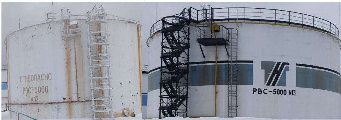
Рисунок 3 – Общий вид резервуаров с заводским номером 12 и 13
