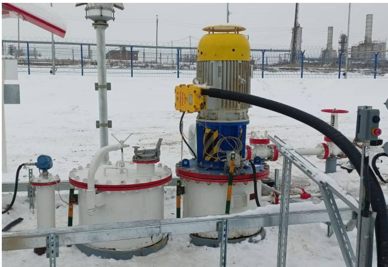
Рисунок 2 – Общий вид резервуара ЕП-5-1600-2-А-СО-У1
