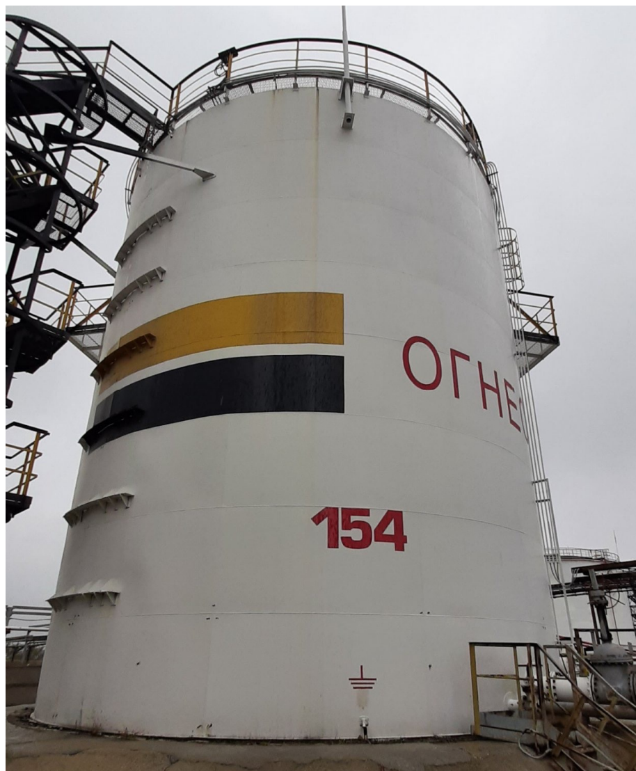
Рисунок 1 – Общий вид резервуара РВСП-1000 №154
