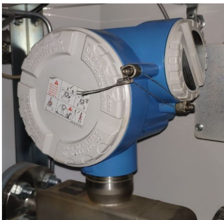
Рисунок 5 - Пломбировка расходомера массового LPGmass
