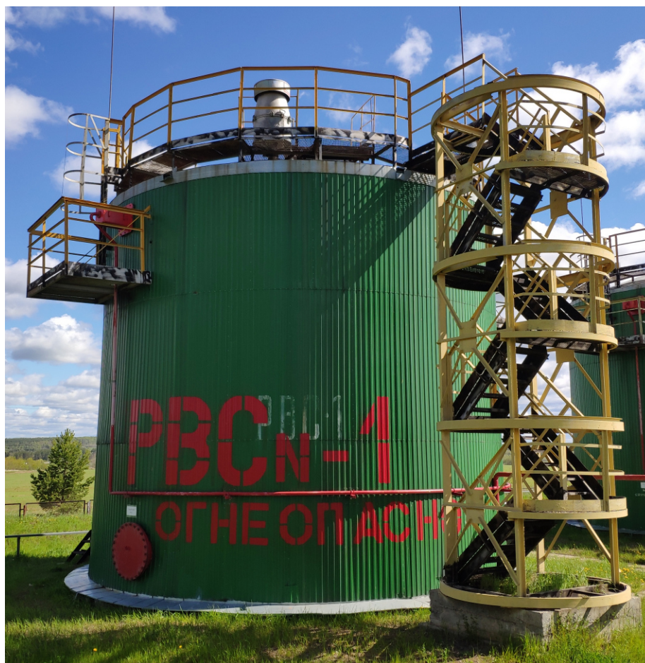
Рисунок 2 – Общий вид резервуара РВС-400
