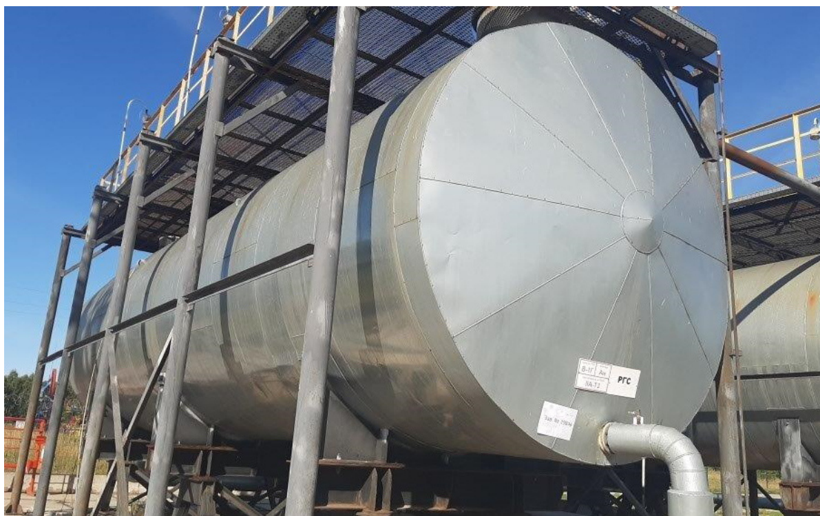
Рисунок 3 – Общий вид резервуара РГС-100 зав.№19844
