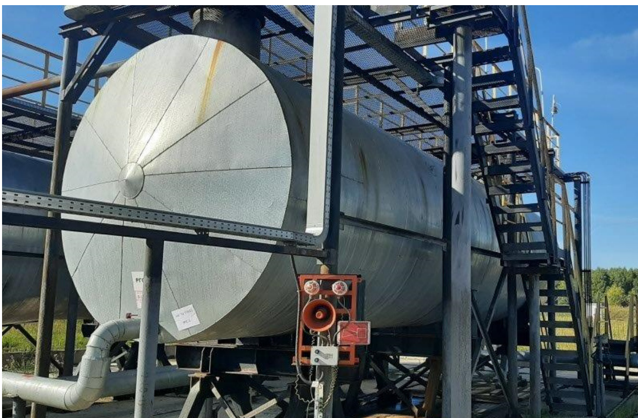
Рисунок 2 – Общий вид резервуара РГС-100 зав.№19843
