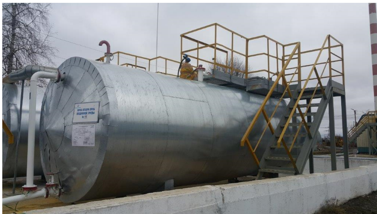
Рисунок 2 – Общий вид резервуара РГС-20 зав.№ 116
