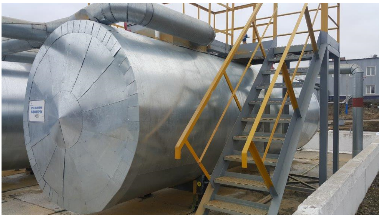
Рисунок 3 – Общий вид резервуара РГС-20 зав.№ 117
