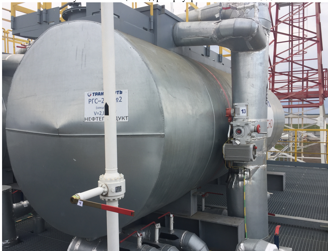
Рисунок 3 – Общий вид резервуара РГС-20 зав.№ 379
