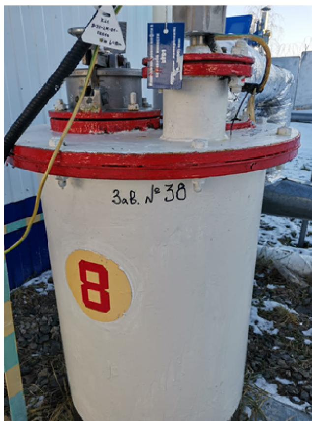
Рисунок 1 – Горловина и измерительный люк
