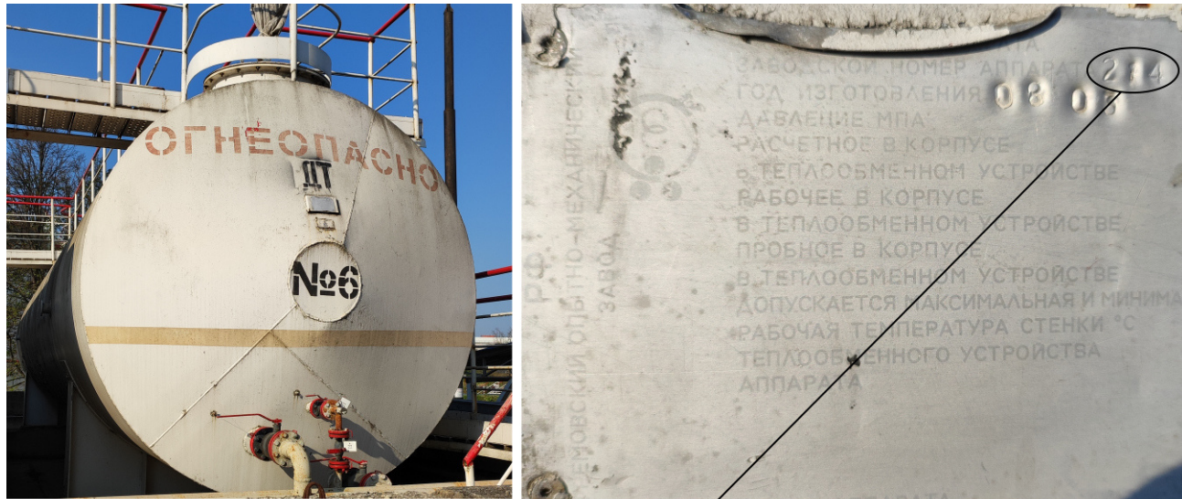
Рисунок 3 – Общий вид резервуара РГС-75 №213 с указанием места нанесения заводского номера
