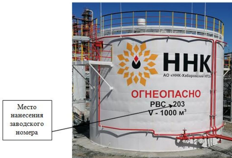
Рисунок 1 - Общий вид резервуаров модификаций РВС-1000 (с 6 поясами) с указанием места нанесения заводского номера
