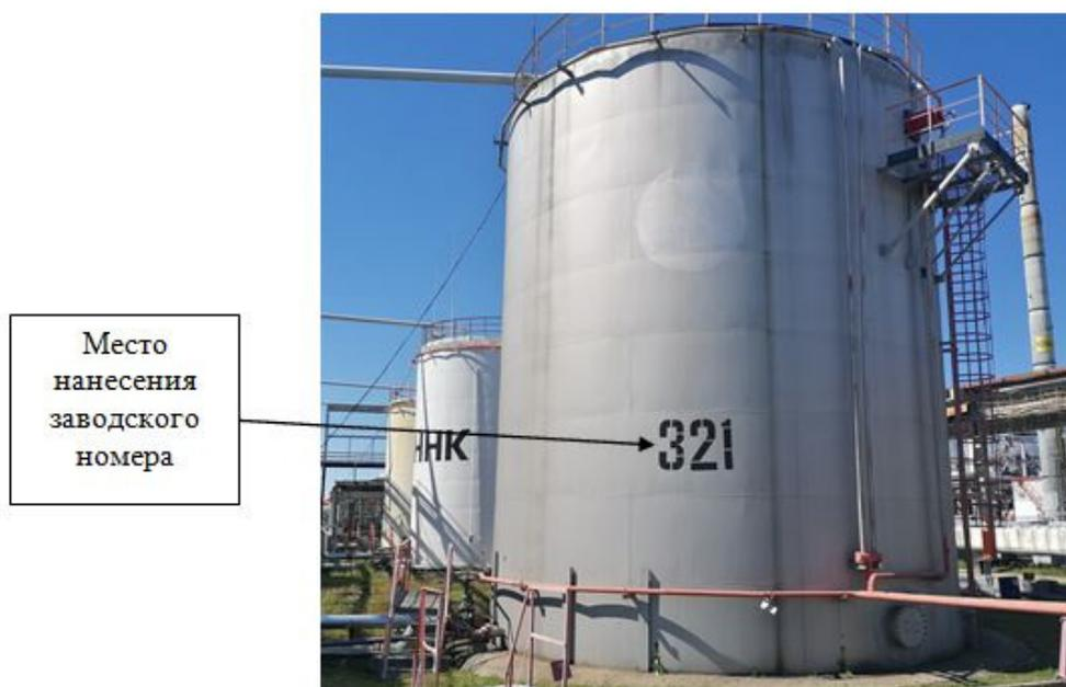
Рисунок 2 - Общий вид резервуаров модификаций РВС-1000 (с 8 поясами) с указанием места нанесения заводского номера
