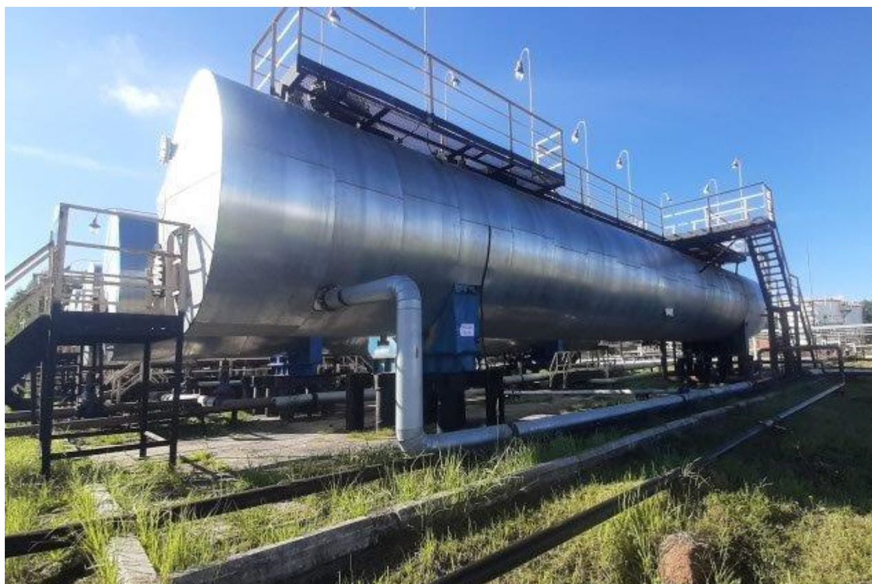
Рисунок 2 – Общий вид резервуара РГС-200
