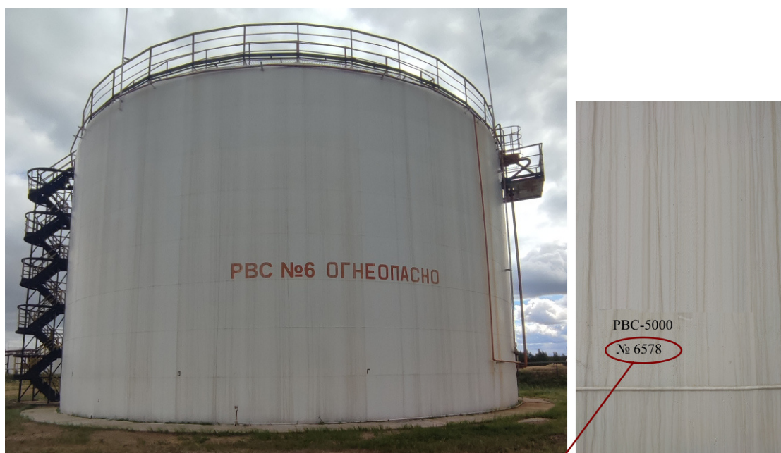
Рисунок 3 – Общий вид резервуара РВС-5000 №683/677 с указанием места нанесения заводского номера
