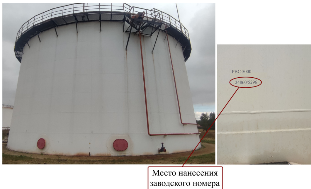
Рисунок 9 – Общий вид резервуара РВС-5000 №24860/5296 с указанием места нанесения заводского номера
