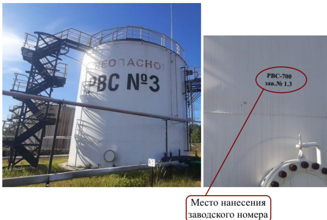
Рисунок 1 – Общий вид резервуара РВС-700 с указанием места нанесения заводского номера
