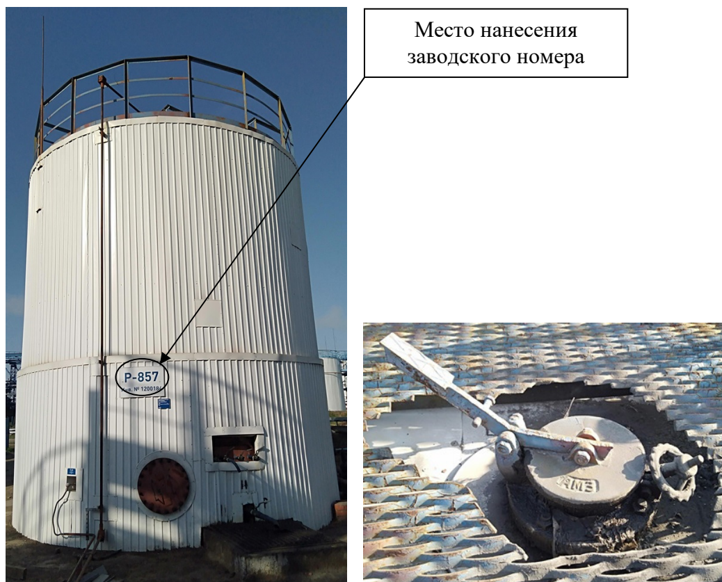
Р и с у н о к 3 – Общий вид резервуара с заводским номером Р-857 и его замерного люка
