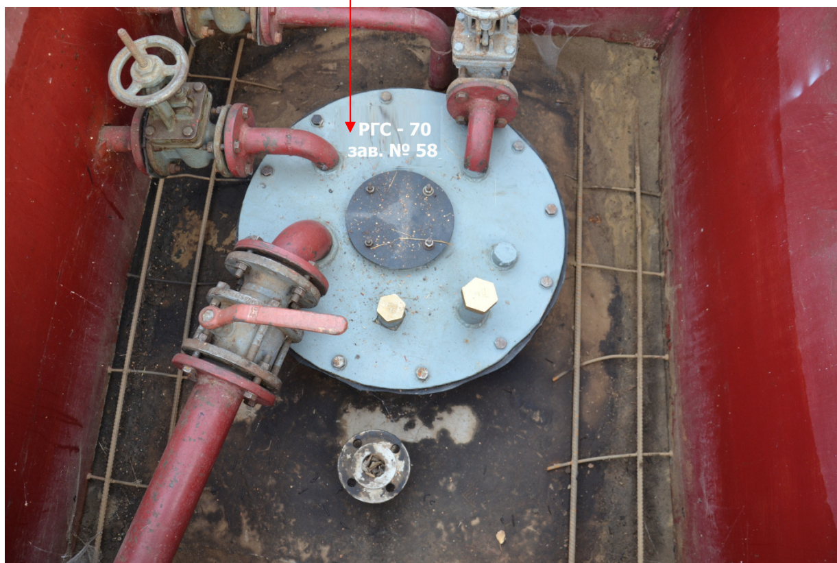
Рисунок 2 - Фотография замерного люка резервуара РГС-70 заводской номер 58, места нанесения наименования, обозначения и заводского номера
