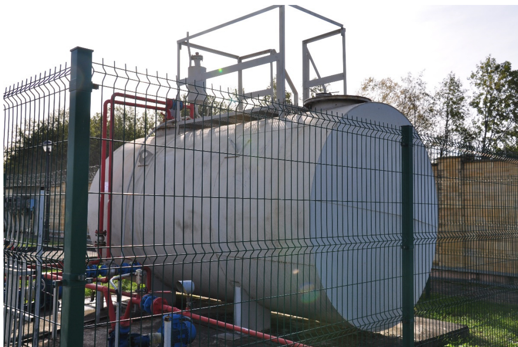
Рисунок 1 - Фотография общего вида резервуара РГС-20Г заводской номер 32
