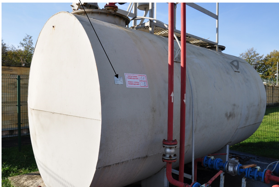
Рисунок 3 – Фотография резервуара РГС-20Г заводской номер 32 с указанием места нанесения наименования, обозначения и заводского номера
